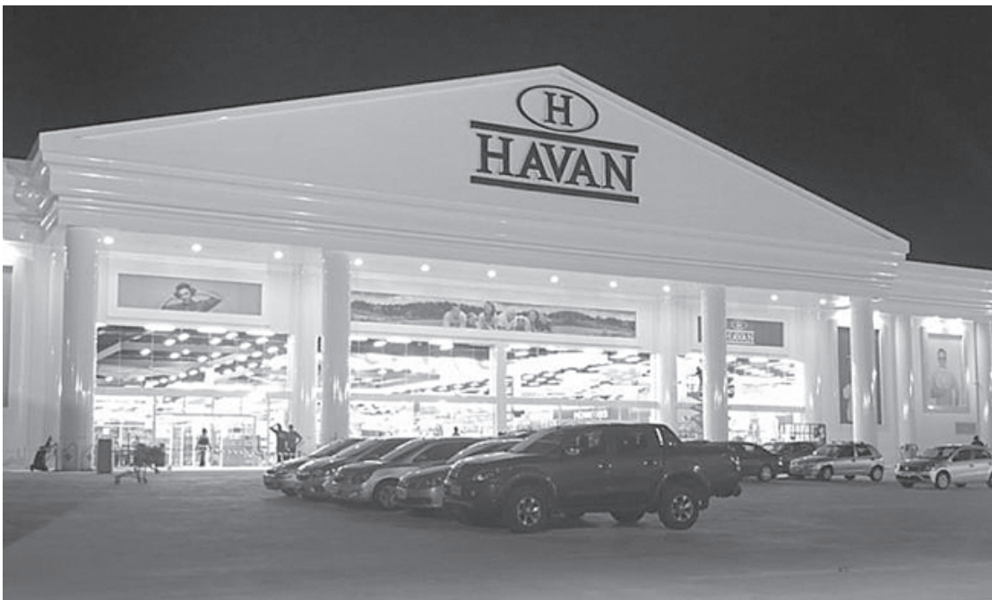
Foram contratados cerca de 300 profissionais para a construção da megaloja
